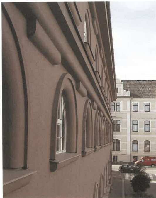
Pohled na průčelí budovy v Jirsíkově ulici
