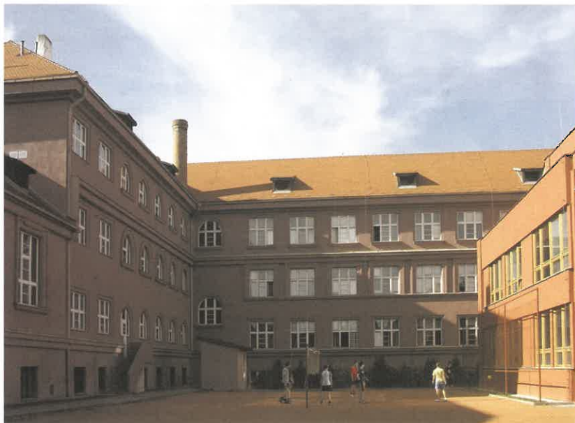
Pohled na všechna tři křídla budovy ze školního dvora
